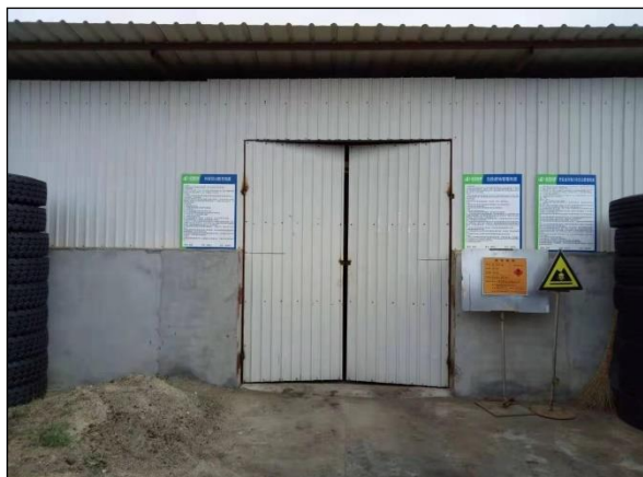
危险废物暂存场所
