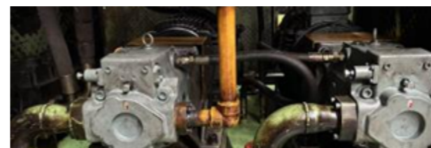
液压站电机改造
